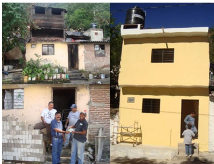
Figura 4. Apoyos del CTOJ para la reconstrucción de la casa siniestrada.
